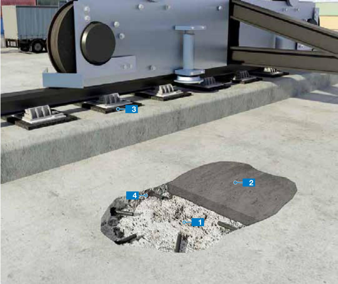
Ripristino pavimentazione in calcestruzzo e ancoraggio della via di corsa di un carro ponte
