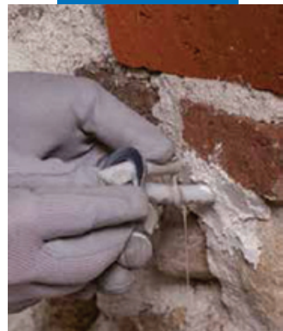
Закупоривание инъекционных трубок
