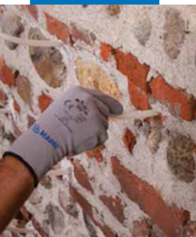
Установка небольших инъекционных трубок
