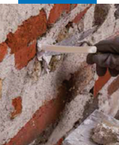
Фиксация инъекционных трубок на месте
