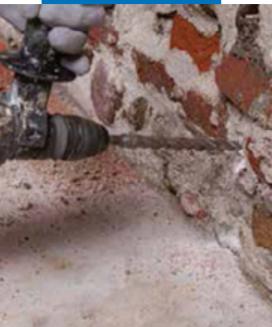
Сверление отверстий
