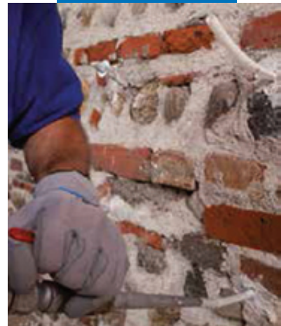
Инъектирование MapeWall Inject & Consolidate
