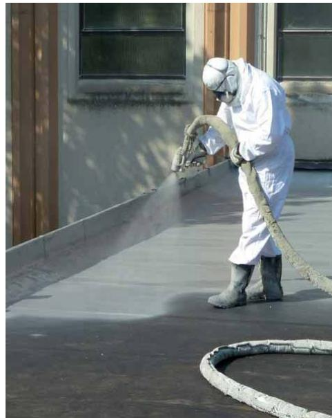
*PURTOP 400 M* ir viena no membrānām *PURTOP SYSTEM ROOF*, kas ir hidroizolācijas sistēma plakanajiem jumtiem (jumti, kas piemēroti gājēju noslodzei, jumta dārzi) un *PURTOP SYSTEM DECK*, kas ir sistēma plakanajiem jumtiem, kas piemēroti transporta noslodzei, tiltiem un viaduktam.
